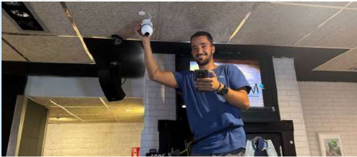
Técnico de Avanza instalando un equipo de seguridad.
