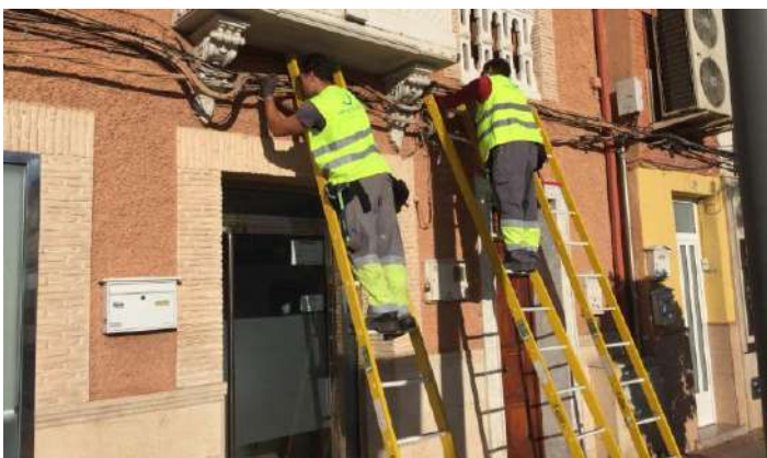
Técnicos desplegando fibra óptica.
