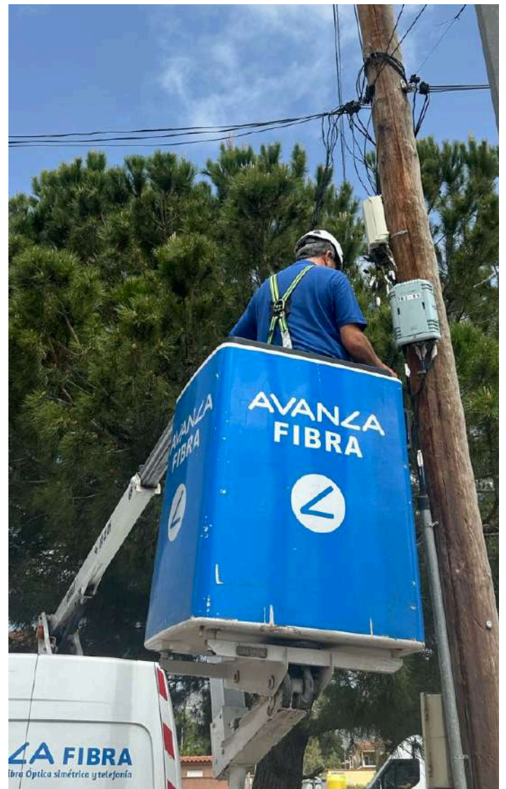
Chencho Ballesta, técnico de Avanza Fibra, instalando en Santomera.
