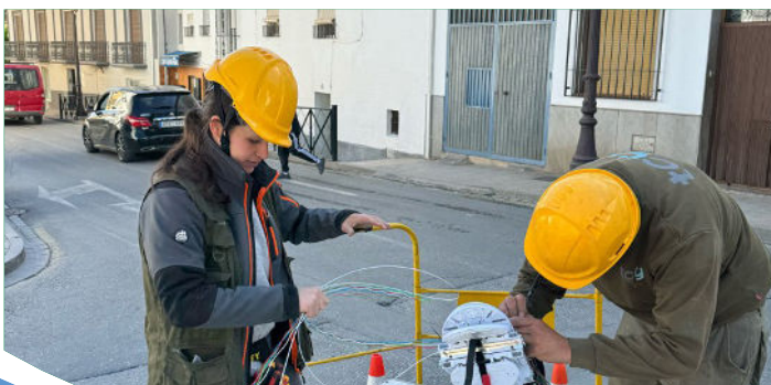
Estrella Gámez durante el trabajo de fusión de Fibra Óptica.
