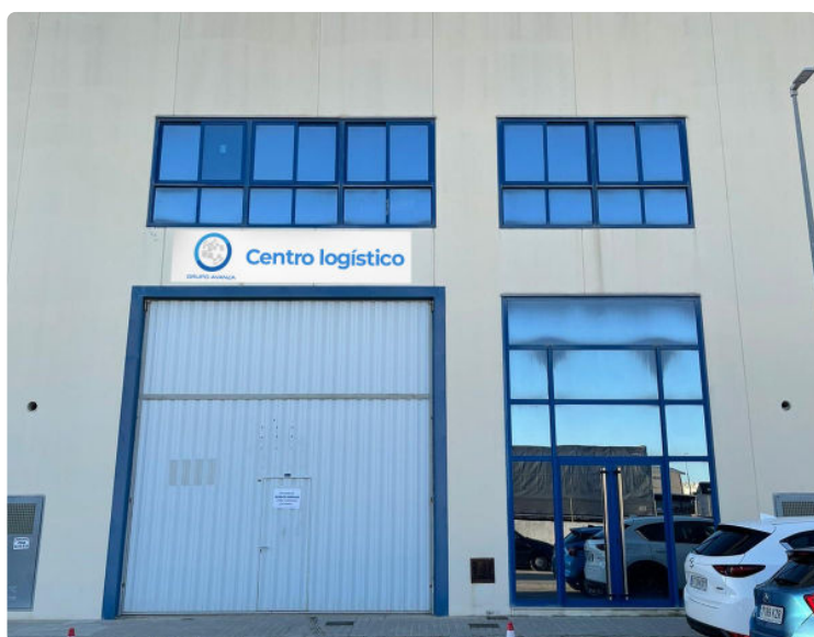
Nave industrial adquirida por Grupo Avanza en Valencia
