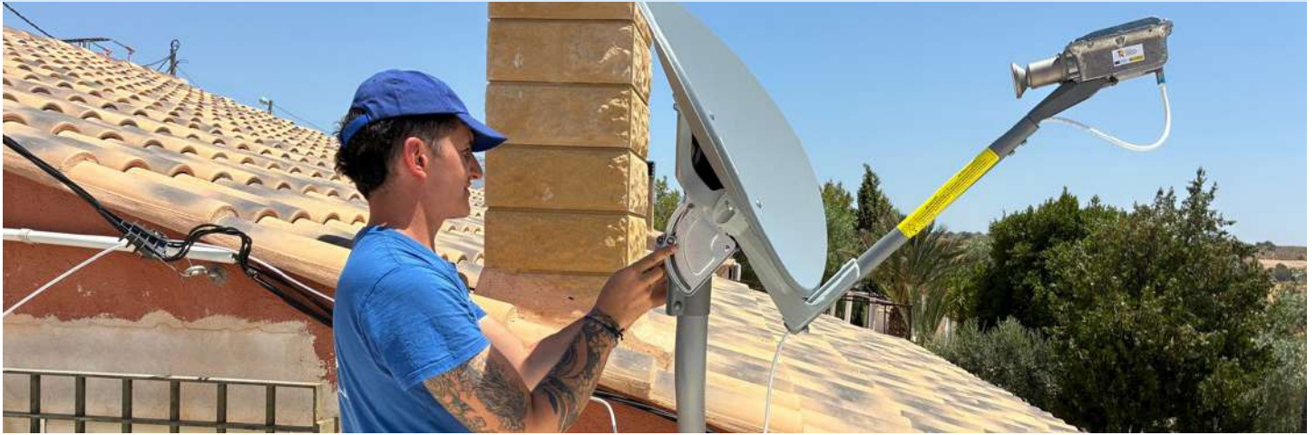
Técnico de Avanza durante una instalación.
