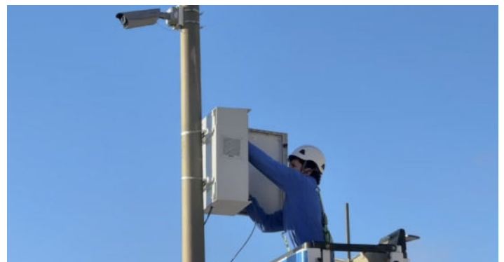
Imágenes del equipo Avanza durante la instalación.
